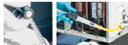
Iniettare il colorante ruotando la maniglia.
